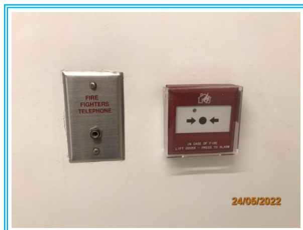
รูปที่ 3-79 ชุดกดแจ้งเหตุแบบใช้มือ
