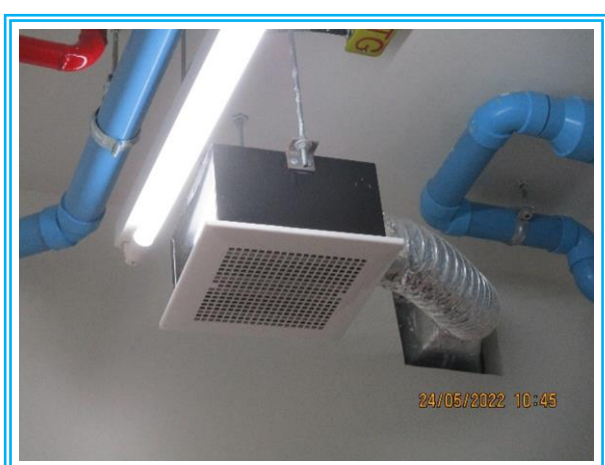
รูปที่ 3-44 พัดลมดูดอากาศ ภายในห้องพักขยะ
