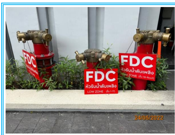
รูปที่ 3-82 หัวรับน้ำดับเพลิง Low Zone และ High Zone
