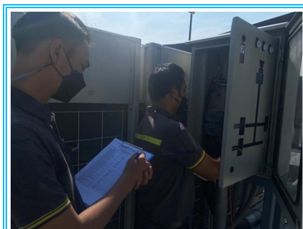
รูปที่ 3-37 เจ้าหน้าที่ตรวจสอบหม้อแปลงไฟฟ้า
