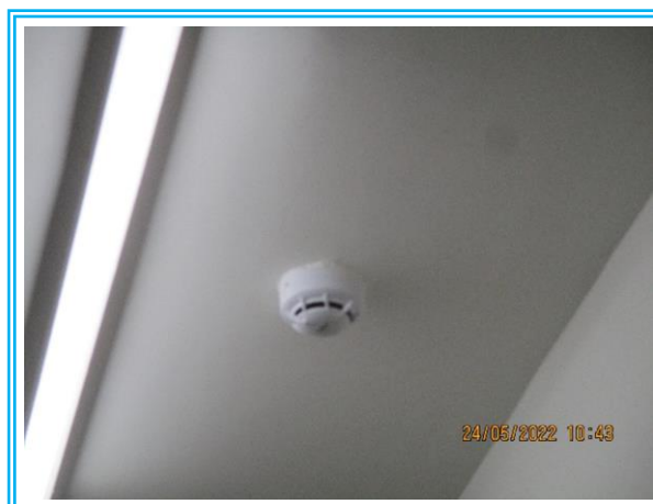
รูปที่ 3-80 เครื่องตรวจจับควัน และเครื่องตรวจจับความร้อน
